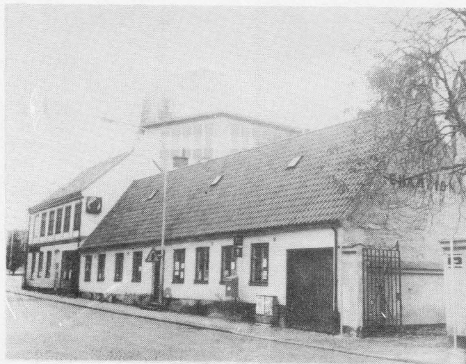
Här Bredgatan 28. Man ser att gatan före de stora uppgrävningarna var täckt med gatsten, ett utmärkt barriadmateriel. Foto: Tomas Schlyter.
