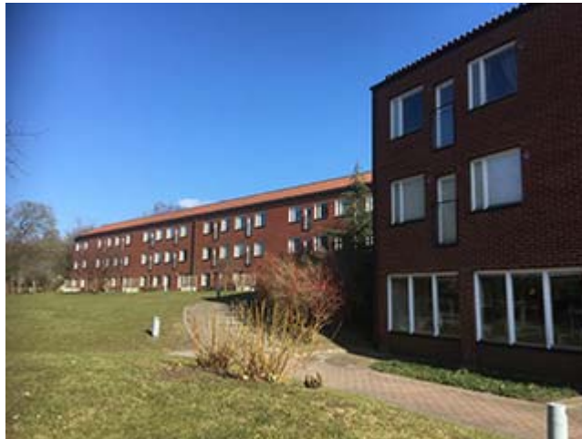
Landsdomarevägen 3 och 5 från cykelvägen
